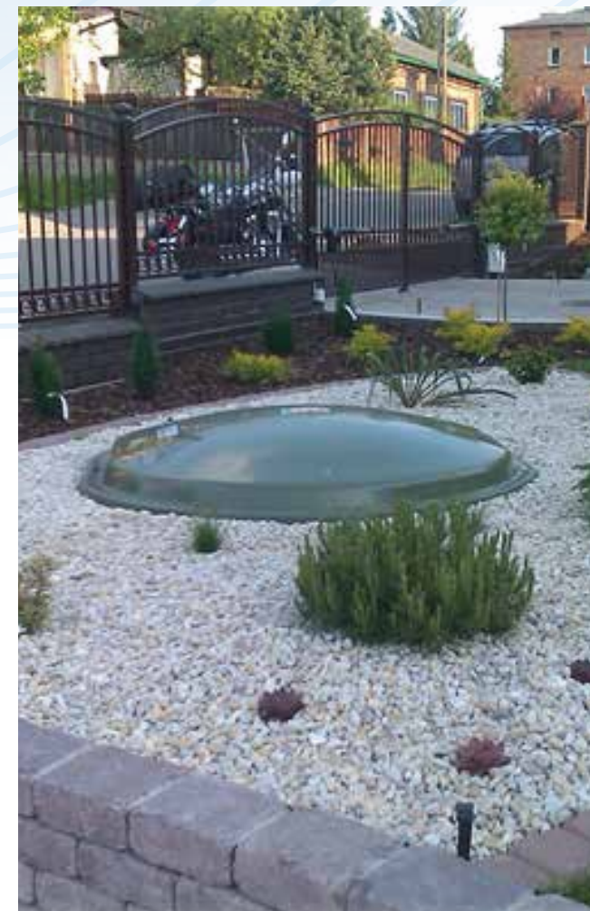
Очисна станція прибудинкова
